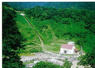
二本木工場 第二水力発電所
