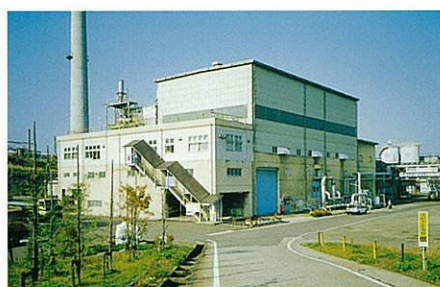
二本木工場 火力発電所
