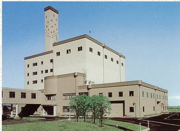
ハイジオンを使用している焼却炉 新潟県 新井頤南クリニックター
