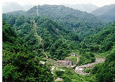
二本木工場 第三水力発電所
