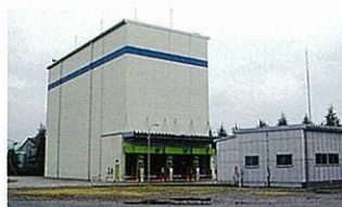
高岡工場 危険物立体自動倉庫
