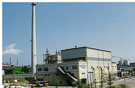
二本木工場 火力発電所
