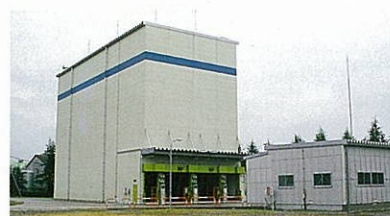
高岡工場 危険物立体自動倉庫
