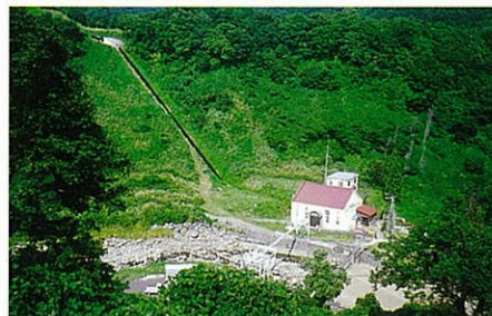
二本木工場 第二水力発電所
