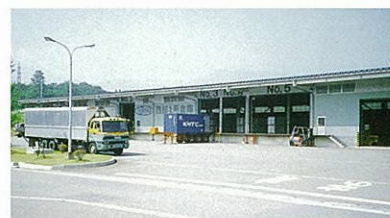
二木工場 物流倉庫
