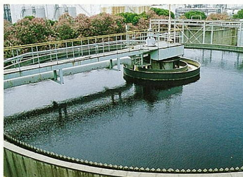
千葉工場 排水処理沈殿槽
