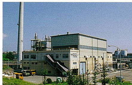
二本木工場 火力発電所
