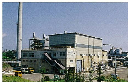
二本木工場 火力発電所
