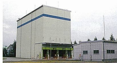
高岡工場 危険物立体自動倉庫
