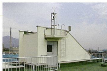
二本木工場 臭気センサー
