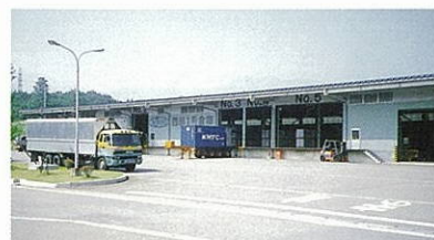
二本木工場 物流倉庫
