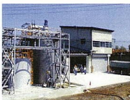
「ろ過石灰石製造プラント」
