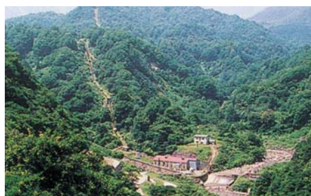
二本木工場 第三水力発電所
