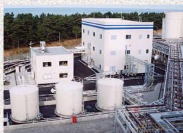
北陸電力株式会社絶縁油リサイクルセンター
