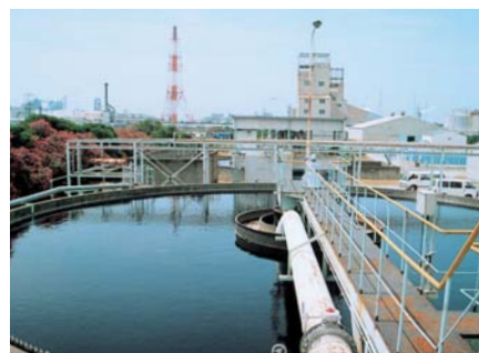
千葉工場 排水処理沈殿槽
