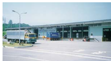
二本木工場 物流倉庫
