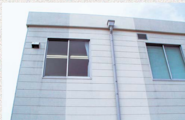
未塗装部分と塗装後1年経過の壁面比較(建物中央の薄色が塗装部分)
