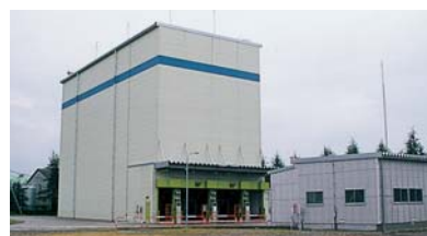
高岡工場 危険物立体自動倉庫
