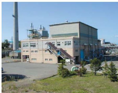
二本木工場 第二火力発電所
