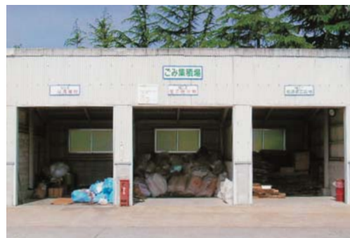
高岡工場 一般廃棄物分別回収場
