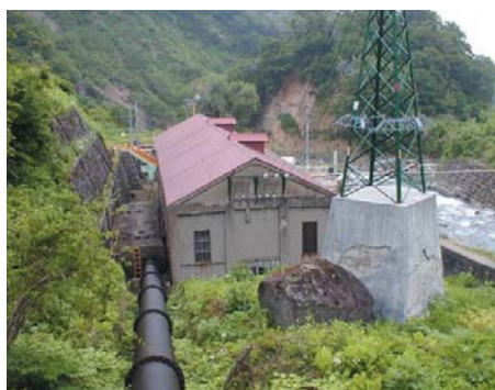
二本木工場 第三水力発電所
