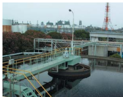
千葉工場 排水処理沈殿槽
