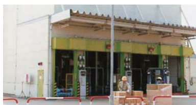
高岡工場 危険物立体自動倉庫
