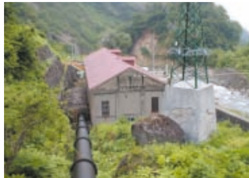
二本木工場 第三水力発電所
