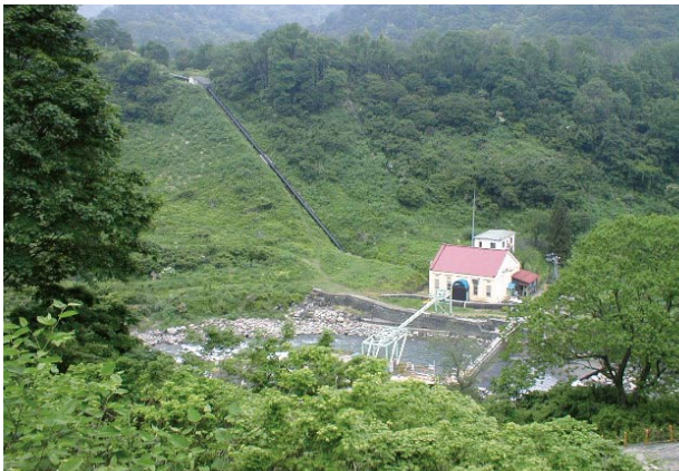
二本木工場 第二水力発電所
