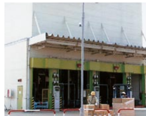
高岡工場 危険物立体自動倉庫
