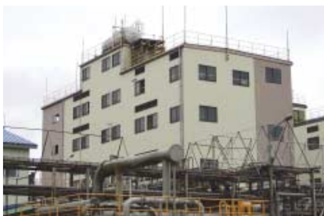
ポリシラン製造プラント
