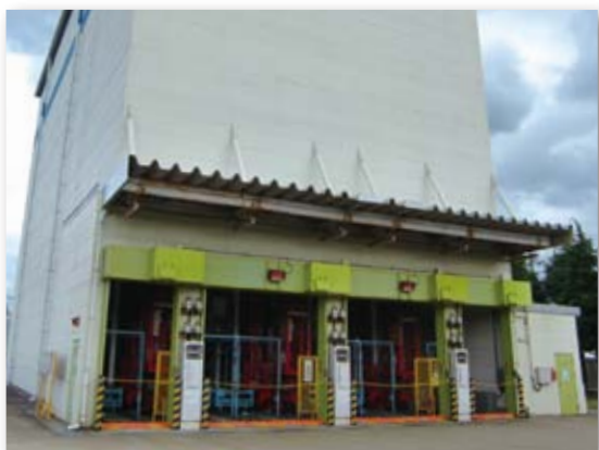
高岡工場 危険物立体自動倉庫
