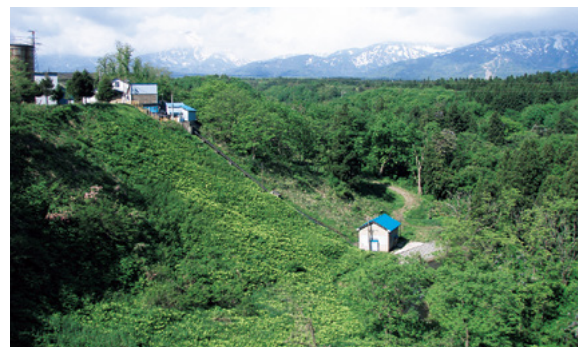
二本木工場の水力発電
