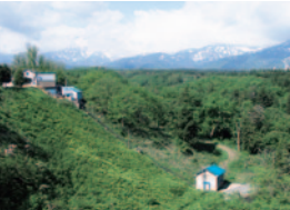
二本木工場の水力発電
